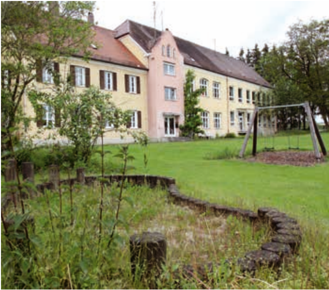
Hat schon bessere Tage erlebt: Das Grundstück der ehemaligen Schule in Mitterndorf. Hier wäre unter anderem Platz für bis zu 40 Sozialwohnungen.
