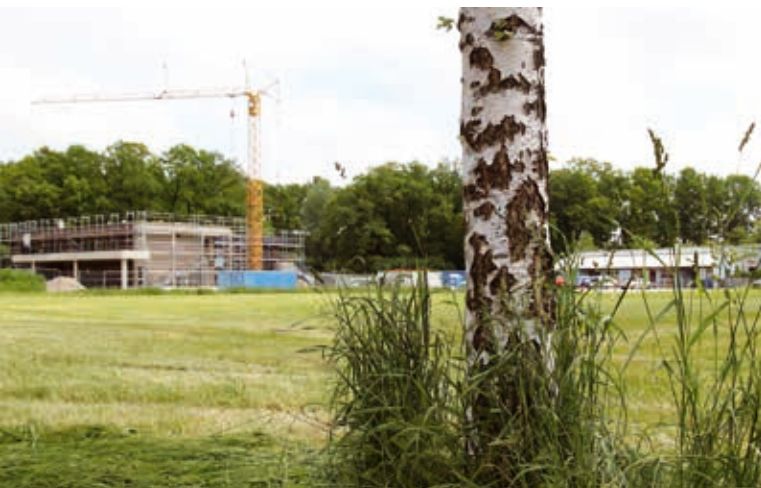
Auf diesem Grundstück am Otto-Kohlhofer-Weg ist Platz für etwa 65 Wohnungen. In unmittelbarer Nähe befinden sich der Rohbau der neuen Kinderkrippe und der Kindergarten Brummkreisel.
