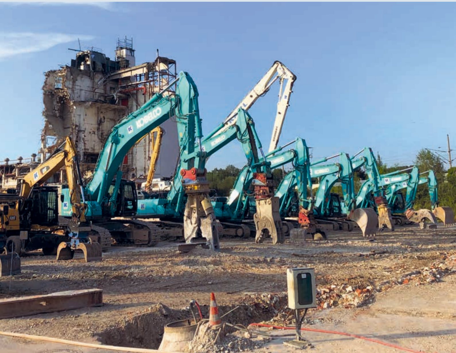
Abrissarbeiten auf dem ehemaligen MD-Gelände (S. 10/11)
