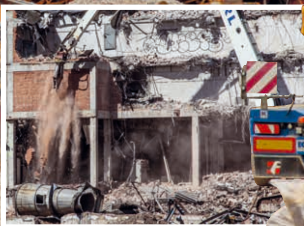
Großes Gerät: Abrissmaschinen reißen Mauern und Gebäude Stück für Stück ein.
