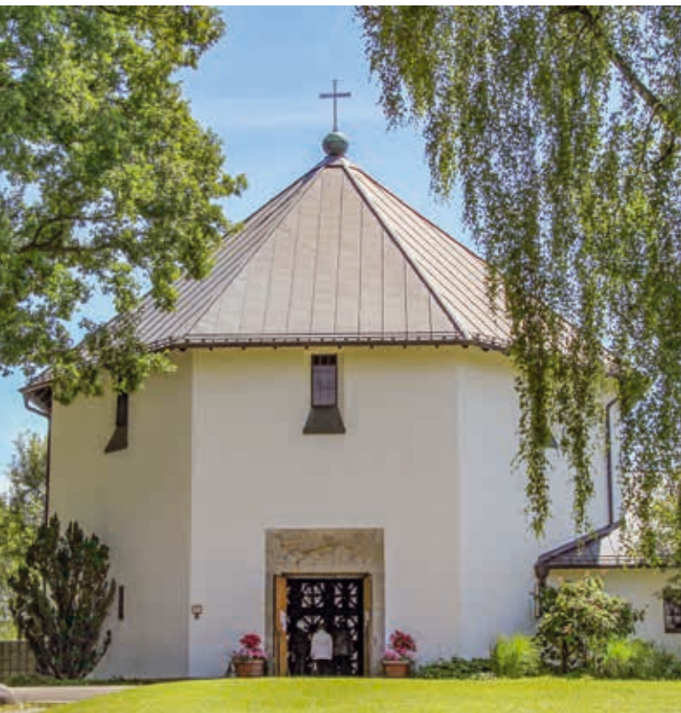
Was in der Aussegnungshalle am Waldfriedhof gesprochen oder gesungen wird, lässt sich jetzt dank verbesserter Raum-Akustik viel besser verstehen.
