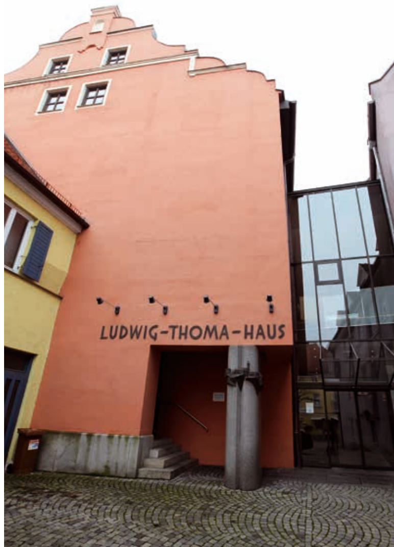
Teurer Brandschutz: Ins Thoma-Haus müssen in den kommenden Jahren circa 3 Millionen Euro investiert werden.
