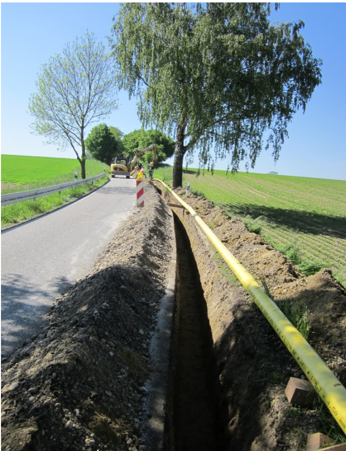
Netzerweiterung Pellheim im Mai 2014
